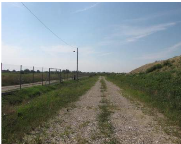
Protupožarni put (između ograde i tijela odlagališta)
