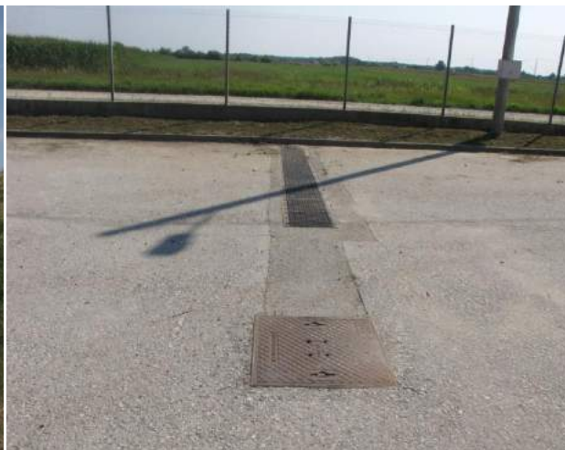
Prostor za pranje vozila sa separatorom ulja i masti
