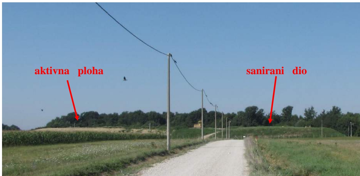
Odlagalište komunalnog otpada "Andrilovac" (pogled s prilazne ceste)
